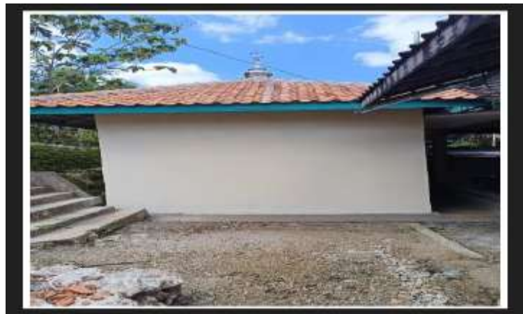
Gambar III.18 Pembangunan musholla Pasar Bedoyo
