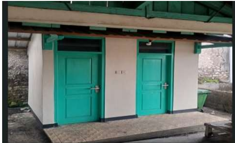
Gambar III.20 Pembangunan mck Pasar Karangtengah
