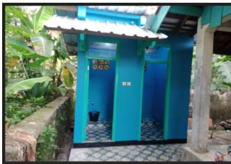
Gambar III.19 Pembangunan mck Pasar Sambeng
