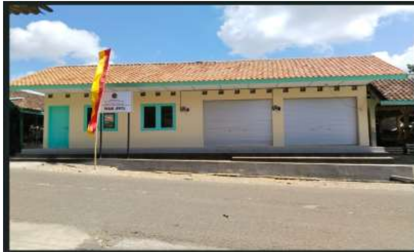
Gambar III.24 Pembangunan kios dan kantor pasar Pasar Jepitu
