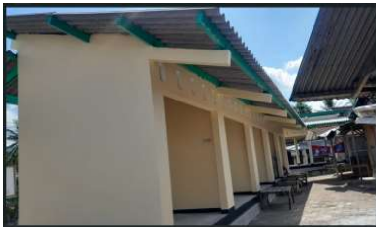
Gambar III.21 Pembangunan kios Pasar Ngalang
