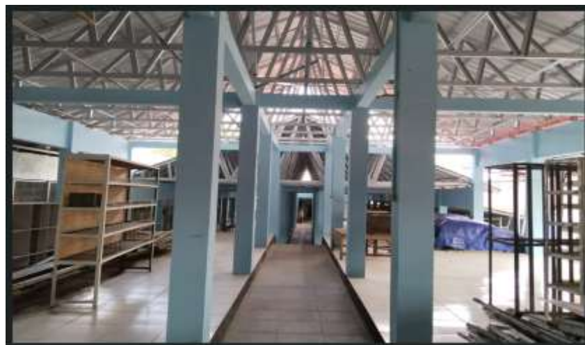
Gambar III.25 Rehab los dan kios Pasar Trowono
